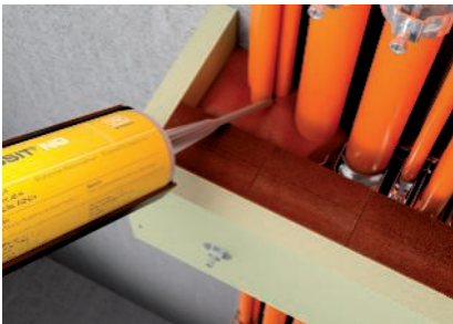
Befüllen mit Schaumstoffblöcken PYROPLUG® Block und Auffüllen der Kabelzwischenräume mit Brandschutzschaum PYROSIT® NG.
