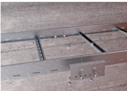
Montage der Längsverbinder mit Flachrundschauben.
