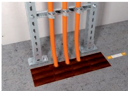
Verschluss der Deckenöffnung mit einem zugelassenen Abschottungssystem.
