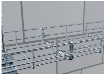
Fertige schraubenlose Stoßstellenverbindung.
