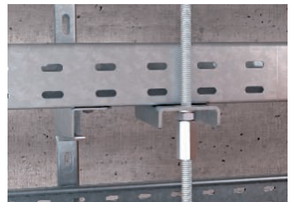
Gewindestangenbefestigung an der Rinne bei mehrlagiger Anordnung.
