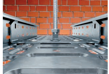
Sicherung der Gewindestange an der Mittenabhängung mit zusätzlicher Sechskantmutter.
