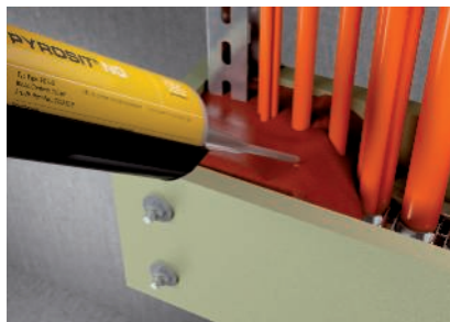
Auffüllen der Kabelzwischenräume mit Brandschutzschaum PYROSIT® NG.
