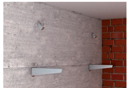
Montage der Ausleger und der schrägen Anschlussbauteile an der Wand.
