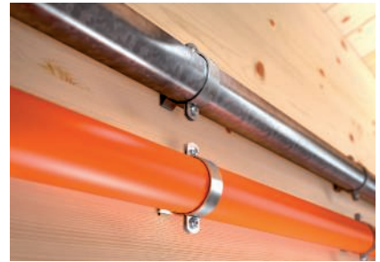
Kabelverlegung mit Einzelschellen und im Rohr, seitlich am Holzbalken.
