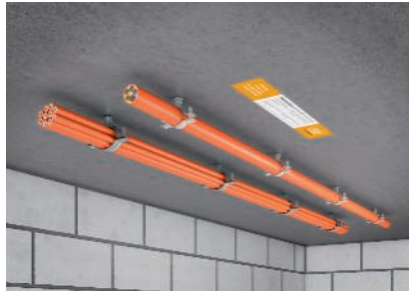
Montage unter der Decke.
