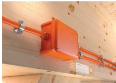
Montage der OBO FireBox am Holzbalken.
