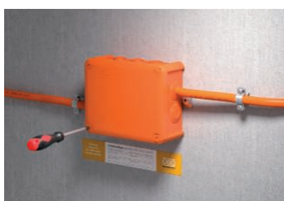
Box mit Deckel schließen und Kennzeichnungsschild anbringen.
