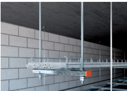
Einlagige Deckenmontage auf Montageschiene.
