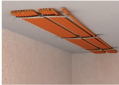
Einfache Kabelinstallation durch seitliches Einlegen der Kabel.
