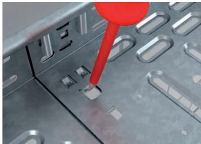
Umbiegen der Sicherungslaschen im Boden.
