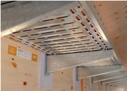
Auslegermontage seitlich am Holzbalken mit hinterlegter Brandschutzplatte.
