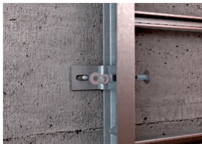
Montage mit verschraubten Befestigungswinkeln.
