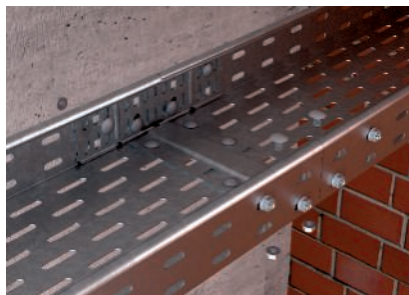
Längsverbinder und Stoßstellenleiste mit Flachrundschauben befestigen.
