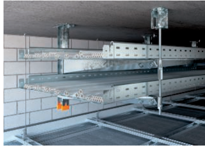
Zweilagige Deckenabhängung mit einseitiger Auslegeranordnung.
