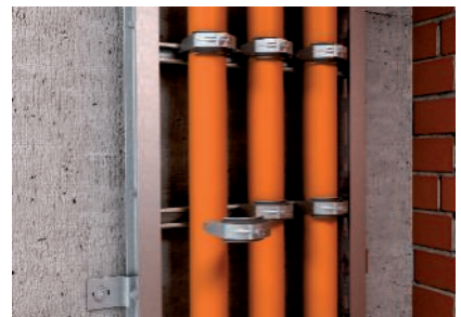
Kabelinstallation mit Bügelschellen 2056 BS U M an den Sprossen der Steigeleiter.
