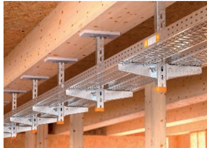
Hängestielmontage unter dem Holzbalken mit hinterlegter Brandschutzplatte.
