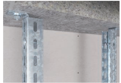
Deckenbefestigung der Leiterholme mit angeschraubten Montagewinkeln.
