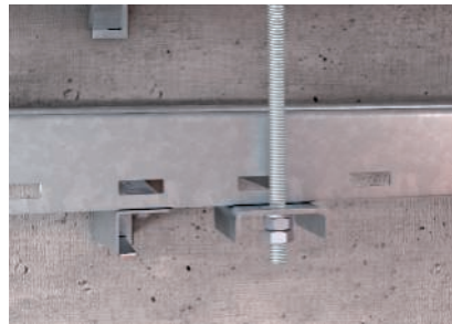
Befestigung der senkrechten Gewindestange am Anschlussbauteil.
