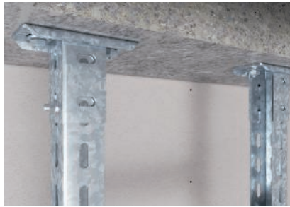
Deckenbefestigung der Leiterholme mit angeschraubten Kopfplatten.
